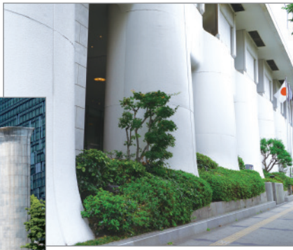
▶ シェラトン都ホテル大阪 正面の列柱 (換気塔)
